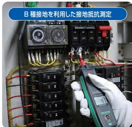
B種接地を利用した接地抵抗測定
